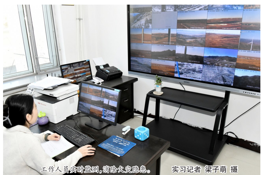
工作人员实时监控，消除火灾隐患。
