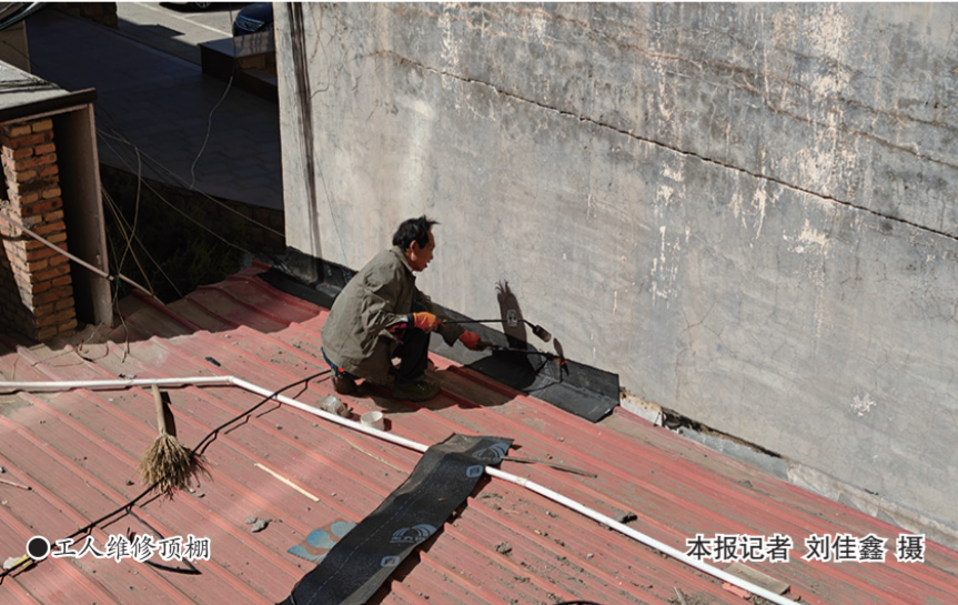
●工人维修顶棚 本报记者 刘佳鑫 摄
