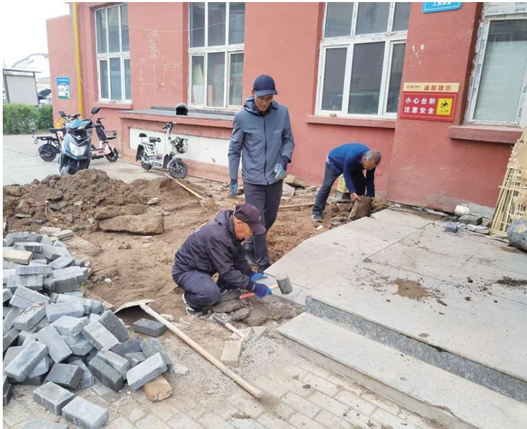
● 工作人员修缮破损路面
