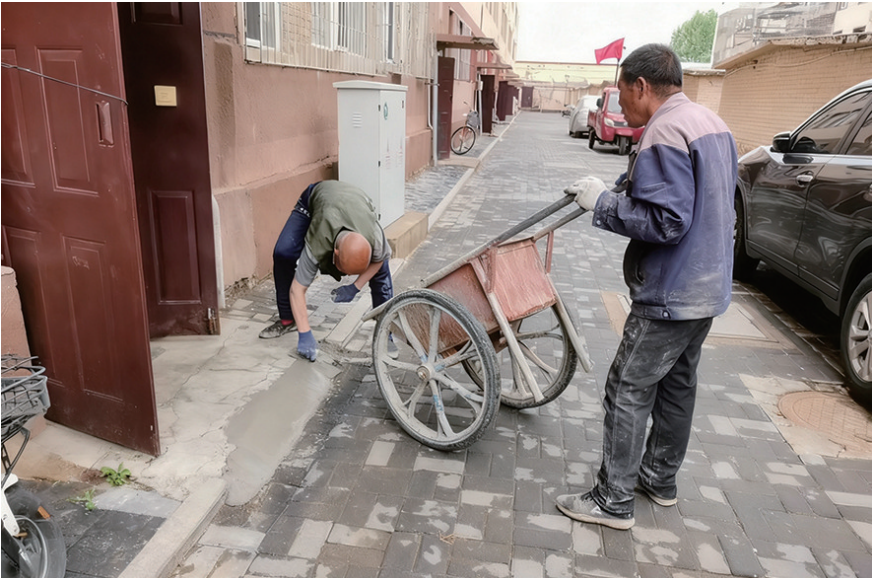
●修补小区破损路面
