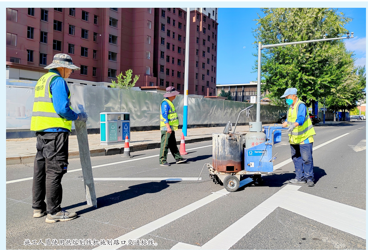
施工人员使用热熔划线机施划路口交通标线。
