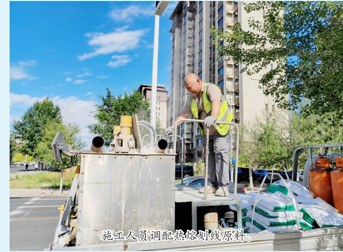
施工人员使用热熔划线机施划路口交通标线。
