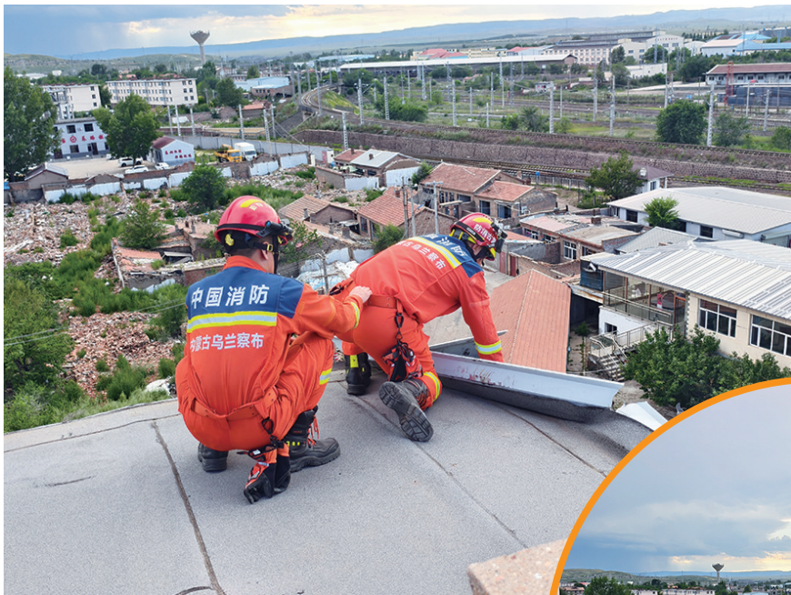
●消防员清除高空安全隐患
