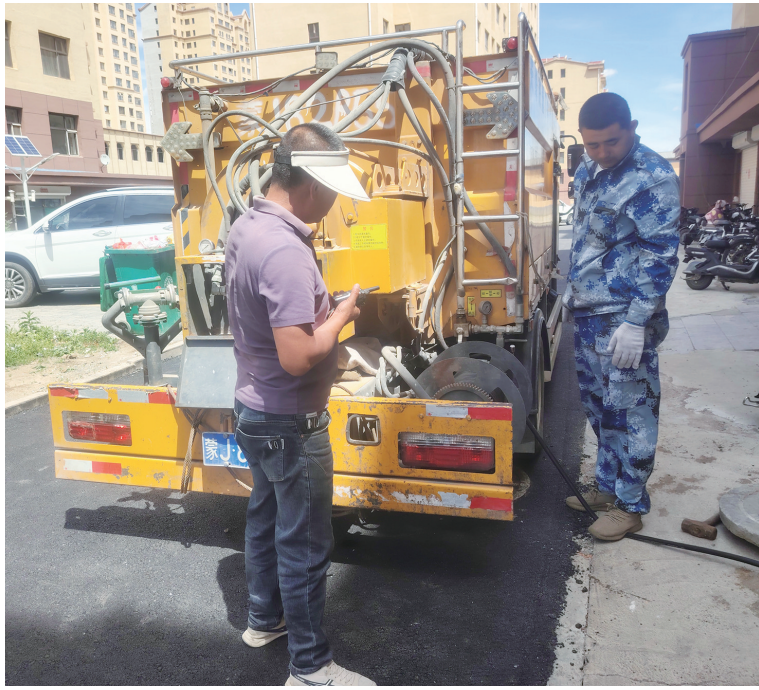
●工人疏通下水
