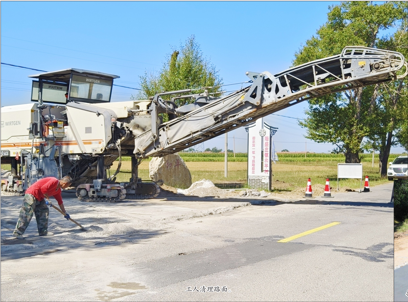
工人对新浇筑路面进行打磨作业。
